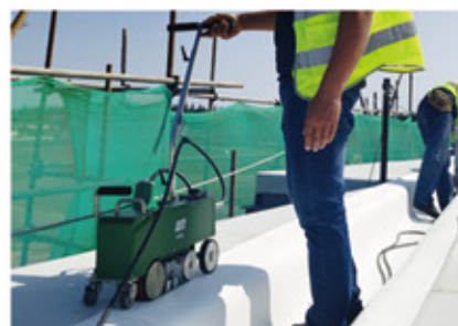
天沟边缘焊接
